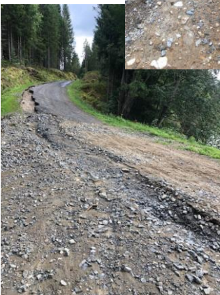
Til venstre: Fra bakken rett etter krysset mot Djupdalen
