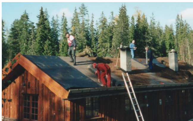
Torvtekking av taket, fra oktober 1999
